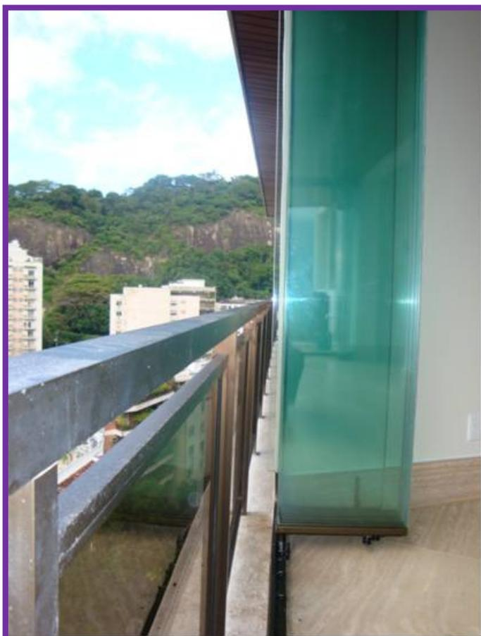
Foto nº 13: Instalação interna da cortina de vidro – recolhimento dos painéis.
