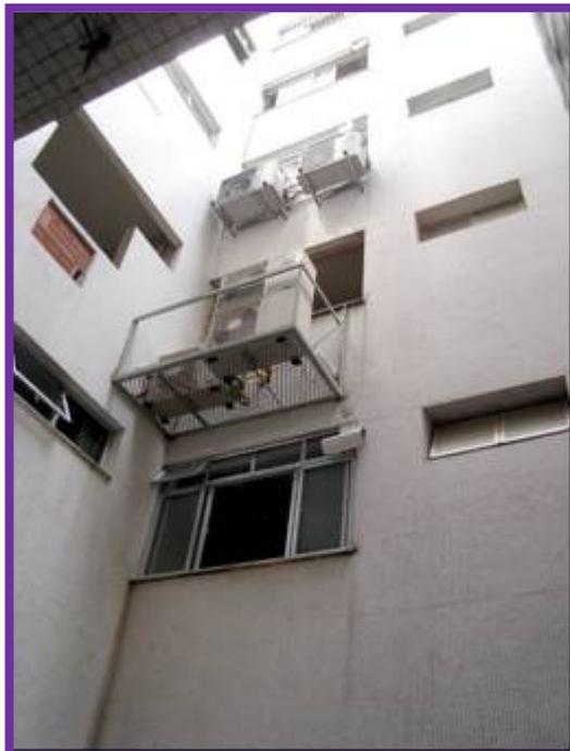
Foto nº 17: Vista da instalação dos condensadores sobre estrutura metálica na unidade 202.
