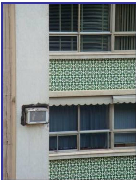
Foto nº 16: Fachada de fundos com instalação de aparelho em posição indevida.
