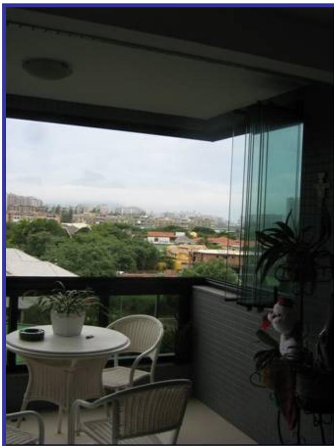
Foto nº 8: Instalação interna da cortina de vidro – recolhimento dos painéis.
