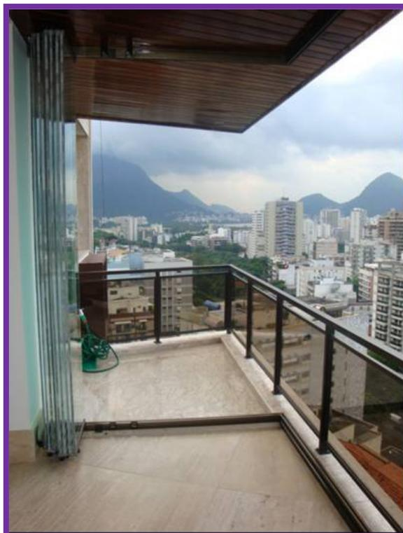
Foto nº 11: Instalação interna da cortina de vidro – recolhimento dos painéis.
