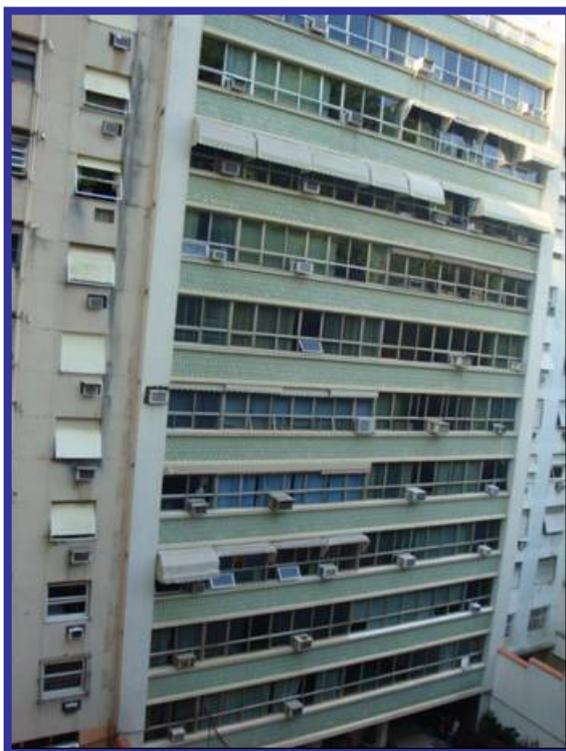
Foto nº 15: Fachada de fundos com instalação de aparelho em posição indevida.
