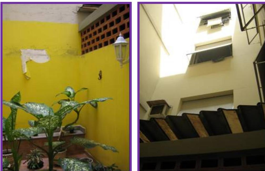
Fotos nº 18 e 19: Área pintada em cor diferenciada e fechamento realizado na unidade vizinha na fachada de fundos da edificação
