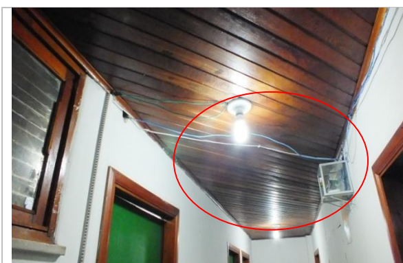
Figura 46: Cabeamento de lógica exposto.
