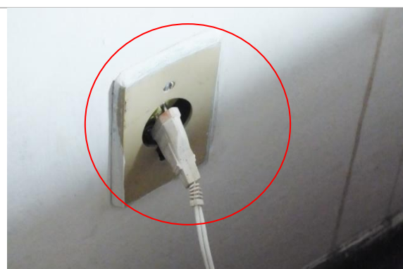
Figura 47: Tomadas danificadas.
