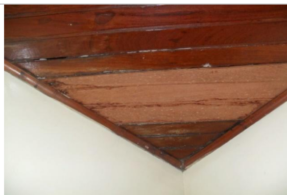
Figura 17: Forro danificado.
